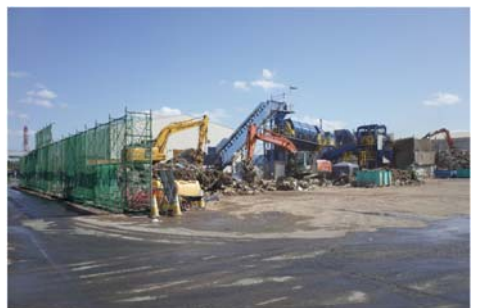
選別前の災害廃棄物（写真上）と選別ヤード（写真下）
