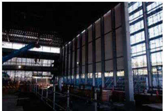
ALC外壁施工状況
